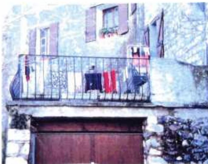
Dans le cas d'une création ou d'une réhabilitation, il est recommandé des garde-corps sobres avec un barreaudage vertical plus ou moins ouvragé tels que l'on pouvait les trouver en Provence.
