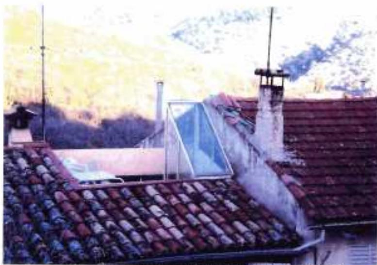
village extra-muros tuiles rondes et tuiles mécaniques
