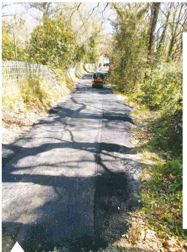
Chemin de la banette, pose d'un enrobé à chaud
