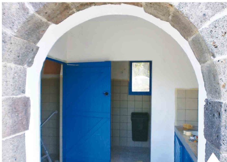
Rafraîchissement des peintures – Toilettes publiques de Nèbre
