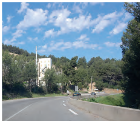
Entrée Sud de St Anne. Un silo qui dénature l'esthétique des lieux
