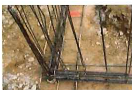
Nœud de chaînage - Continuité mécanique
